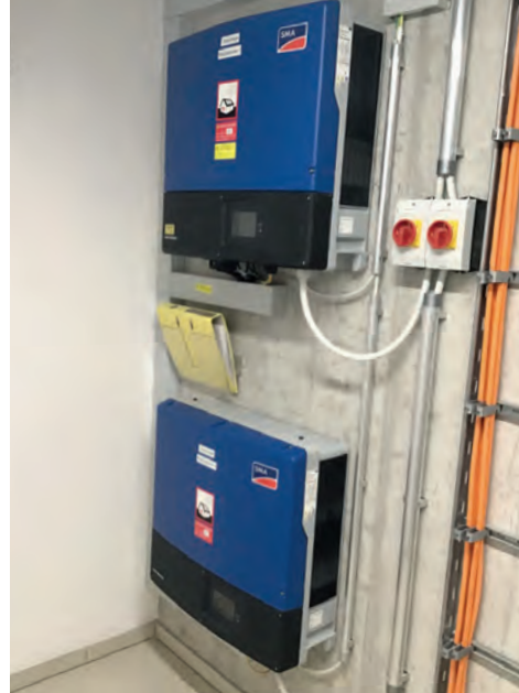
Wechselrichter im IMWIL
